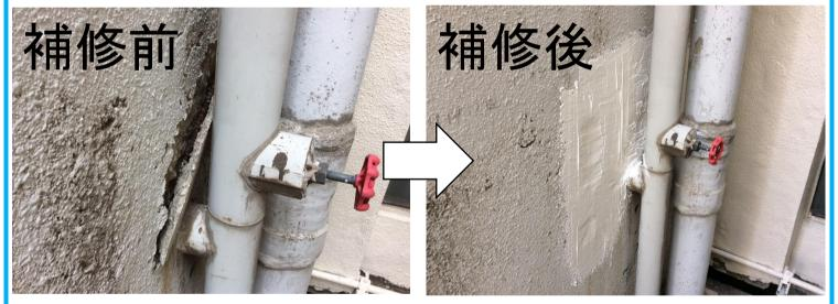
外壁亀裂から配管を支える部分が浮いてしまっています。
