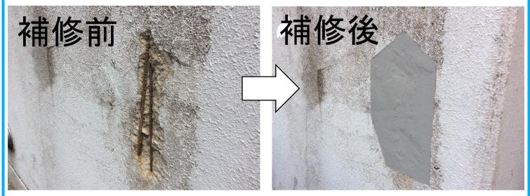
外壁爆裂(鉄筋の露出)補修のち塗装となります。
